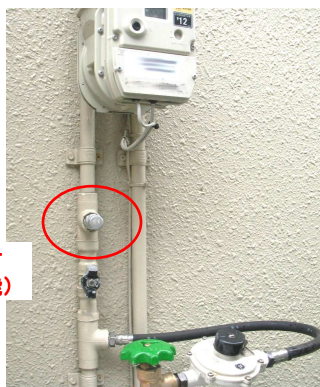
1-1 3)、1-2 2) 調整器出口圧の測定場所（例） （測定が困難な場合は、燃焼器入口圧力を測定する）
