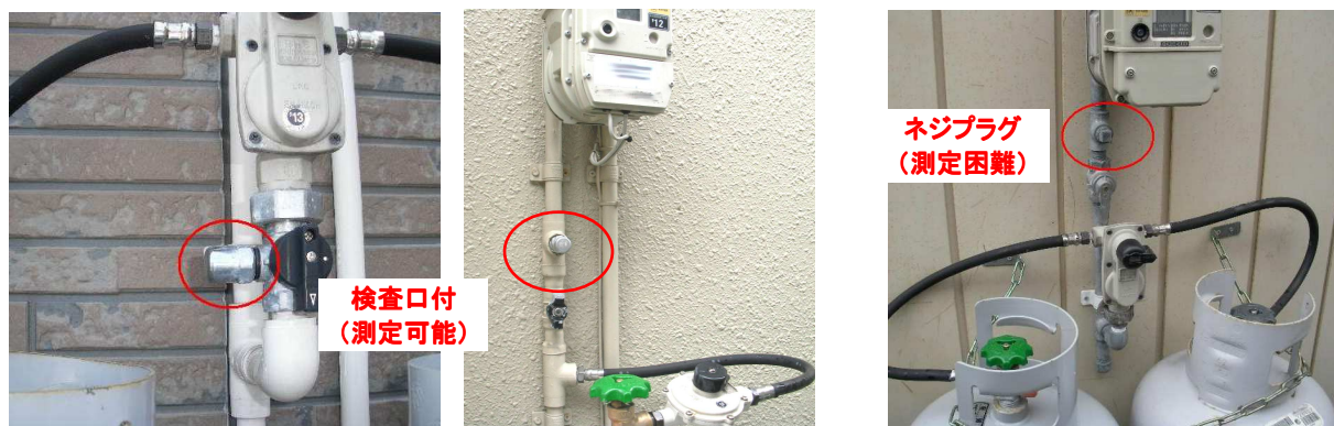
1-1 3)、1-2 2) 調整器出口圧の測定場所 (例) (測定が困難な場合は、燃焼器入口圧力を測定する)
