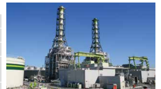
川崎天然ガス発電
